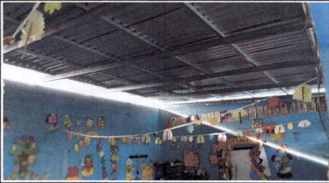
Foto 1: Aula de primero A con el techo terminado
