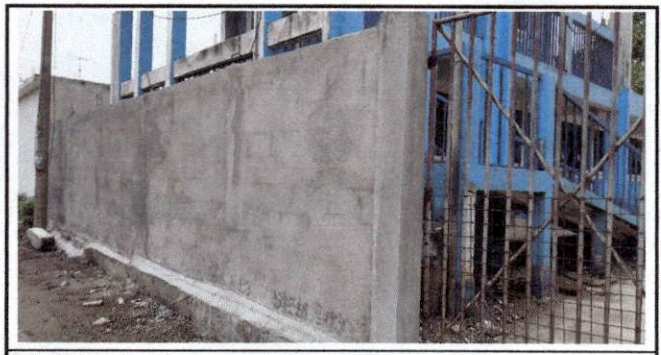
Foto 6: Culminación de reparación de muro perimetral
