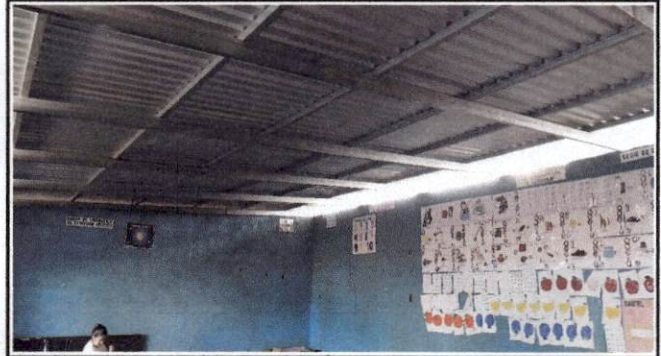
Foto 2: Aula de primero B ya techada
