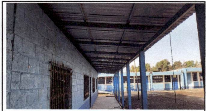
Foto 4: Corredor de aulas techado
