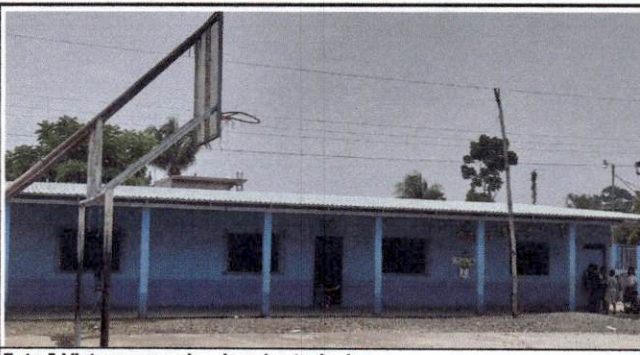
Foto 5: Vista panorámica de aulas techadas
